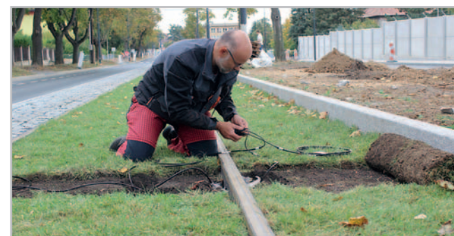
Mgr. Pavel Vítámvás, Ph.D., instaluje čidla, která v kolejišti snímají teplotu a vlhkost Foto Barbora Venclová
