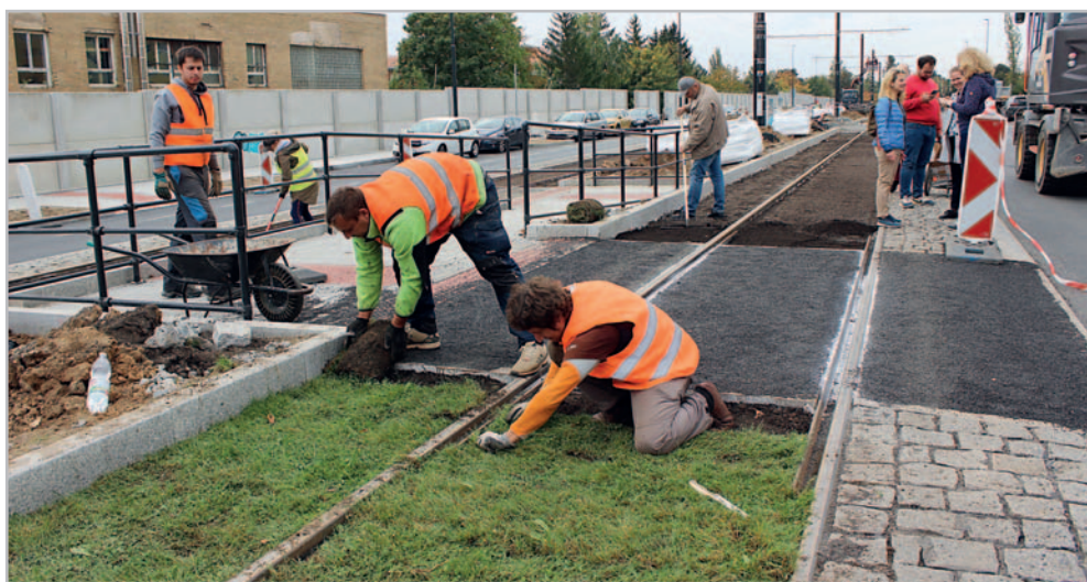
Instalace proběhla při budování nové tramvajové trati na ploše 1064 m 2 Foto Barbora Venclová
