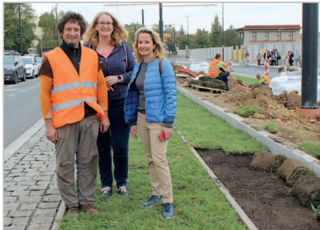
Pavel Brůžek (SEED SERVICE), Ing. Dagmar Janovská, Ph.D., (VÚRV) a Ing. Petra Hlásná Čepková, Ph.D., (VÚRV) při instalování tramvajových svršků v ulici Vlastina Foto Barbora Venclová
